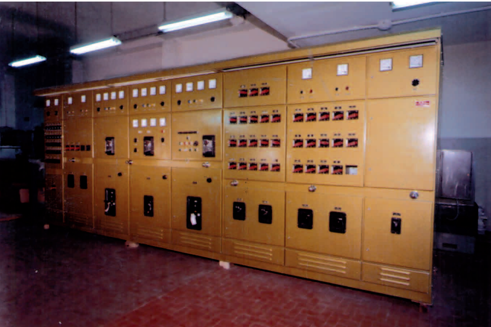
Quadro elettrico principale di una petrolchimica dei Cantieri Navali M&B Benetti
