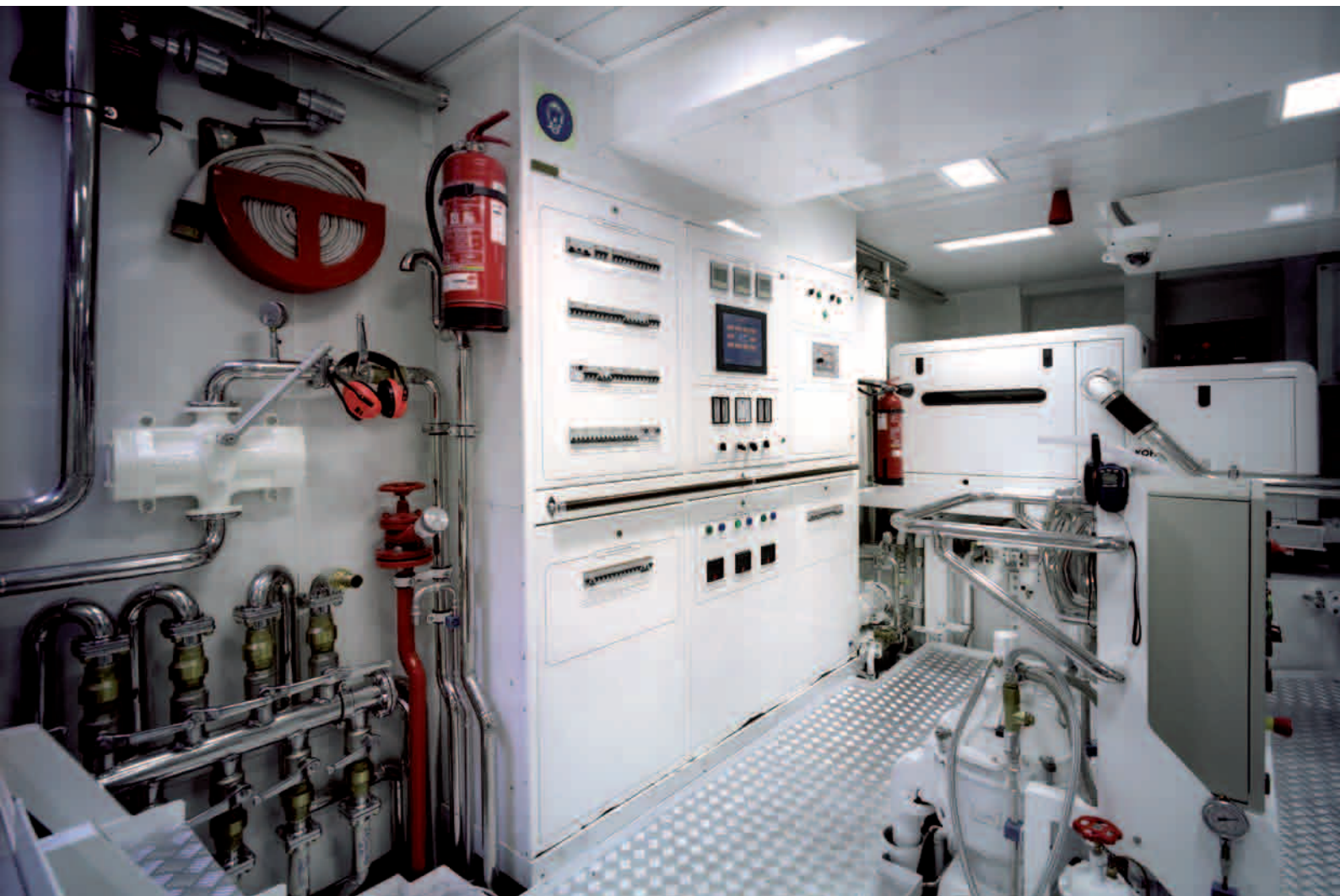
Quadro principale del M/Y Family Day del Cantiere Ugo Codecasa
